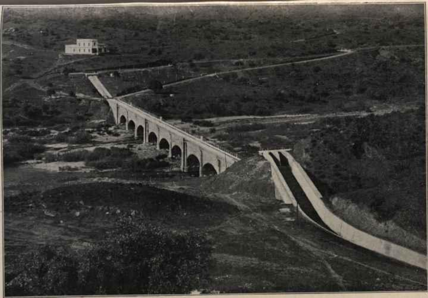
Canal del Guadalmellato. Viaducto. Sifón sobre el río Guadalmellato.
