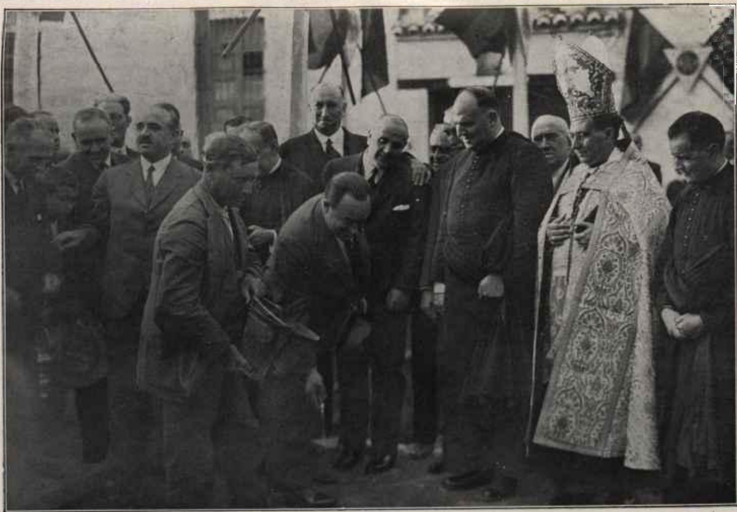
Inauguración de las obras en la Acequia Gorda, (Granada).
