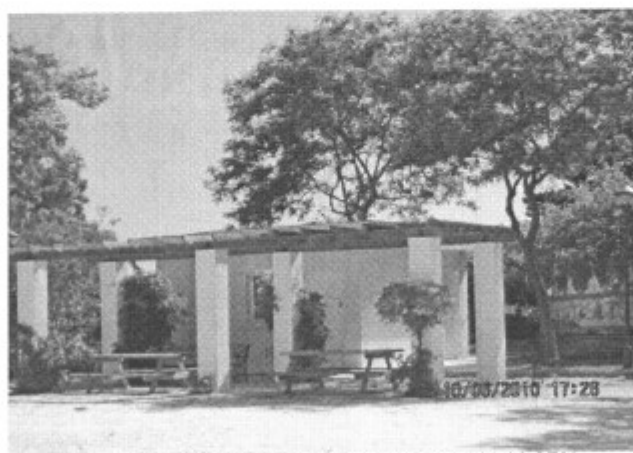
ACTUAL EDIFICIO DE ASEOS Y ALMACEN
