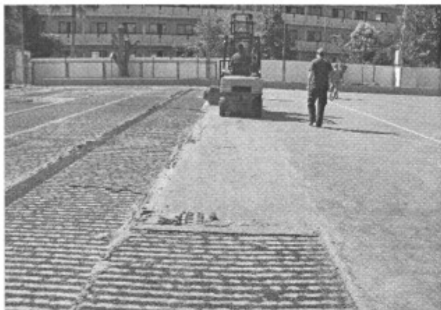
TRABAJOS DE SUSTITUCIÓN DEL CÉSPED ARTIFICIAL EN EL CAMPO DE DEPORTE EL TOMILLAR
