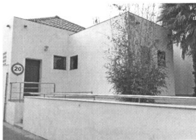
EDIFICIO PRINCIPAL DEL CLUB MUNICIPAL DE RAQUETA ANTES DE LA OBRA DEL ALJIBE.
