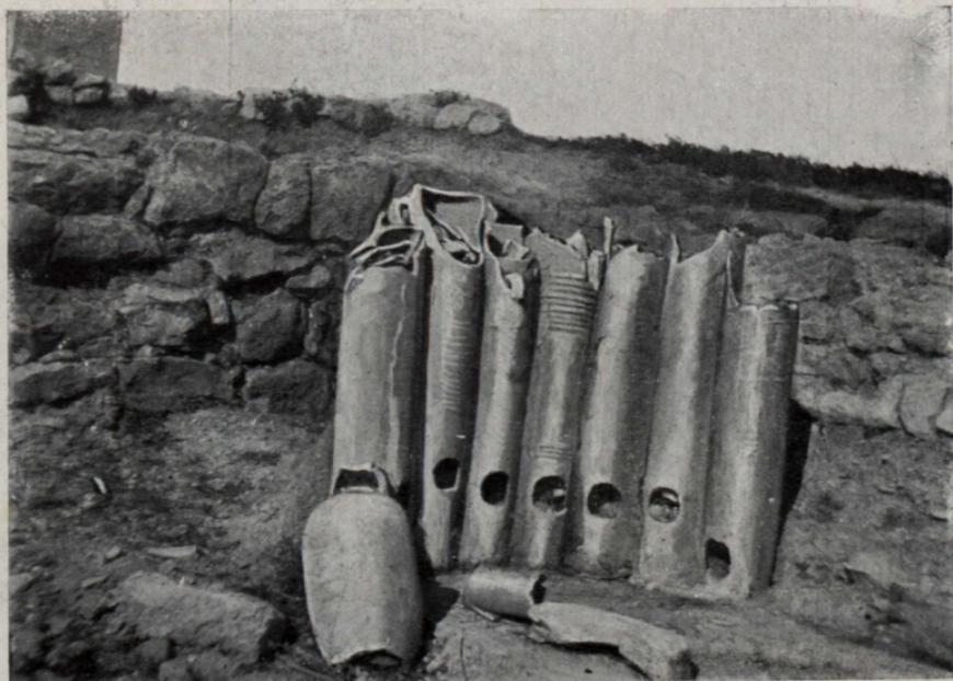
Filtre construit avec des amphores.
