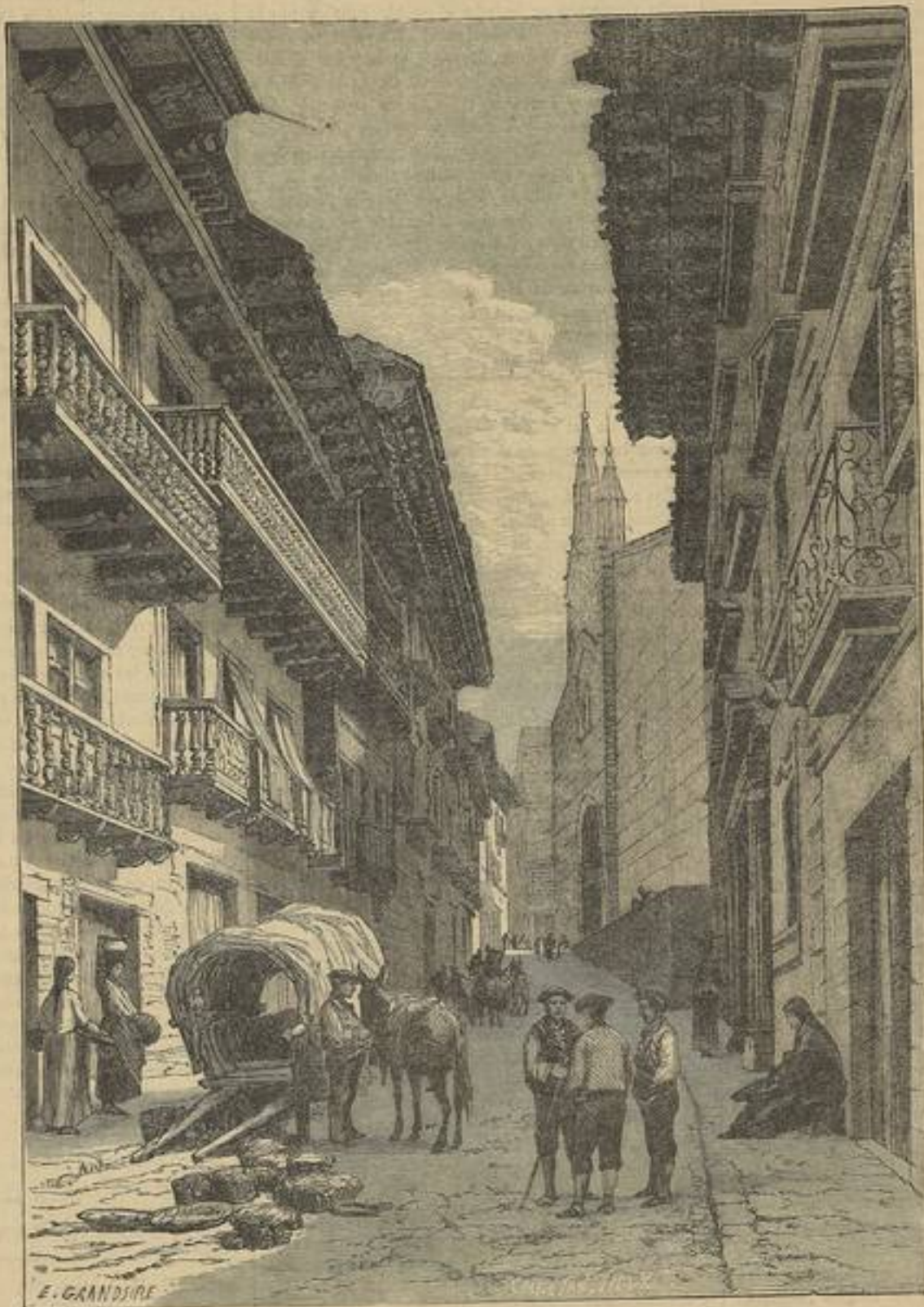
CALLE MAYOR DE PUENTE-RABÍA.
