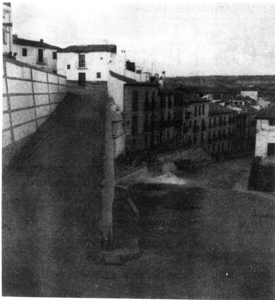
Estado en que ha quedado la Cuesta después de la reforma; el Cerro que aquí había ha quedado como se puede observar, convertido en suave rampa.
