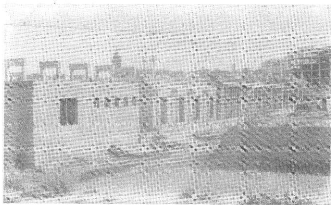
ESTADO DE LAS OBRAS DEL CENTRO DE SALUD DE GUADIX.
