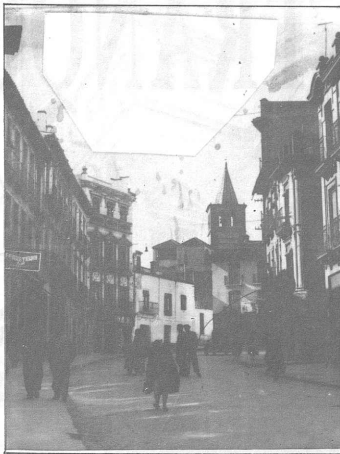
CALLE ANCHA, ANTIGUO CENTRO COMERCIAL
