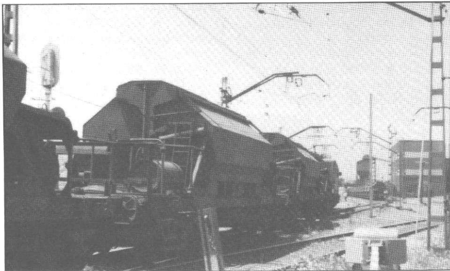
Terminal de carga en las Minas. Foto: Molas.
