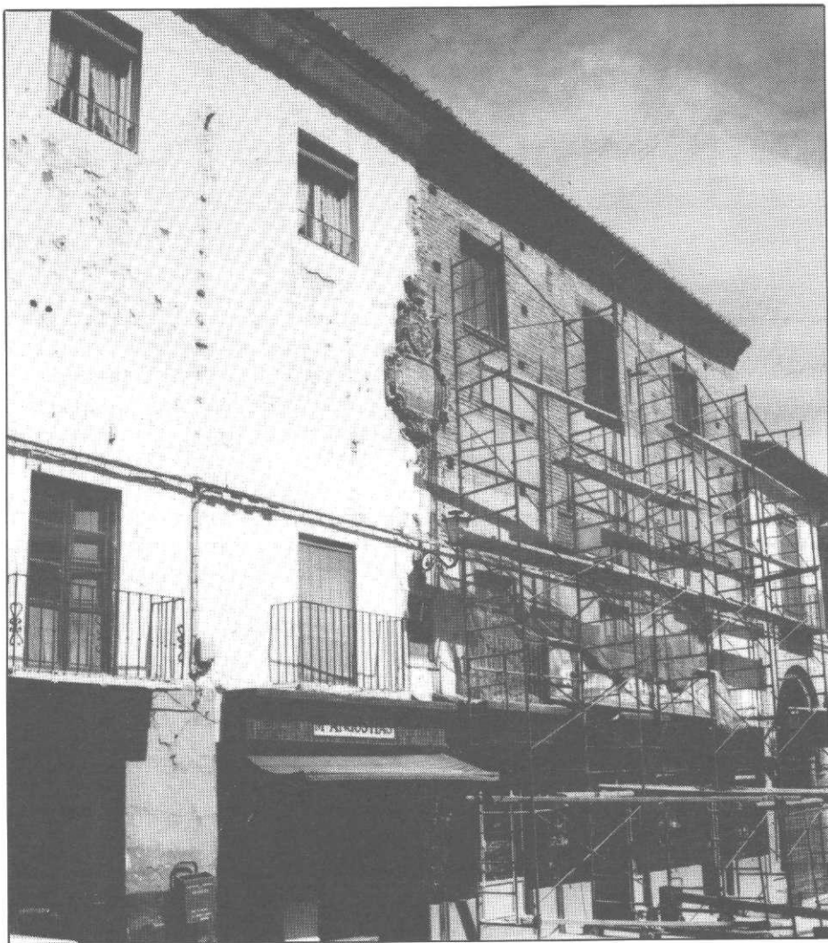
Fachada en rehabilitación del Pósito Municipal. Foto: Picaro.
