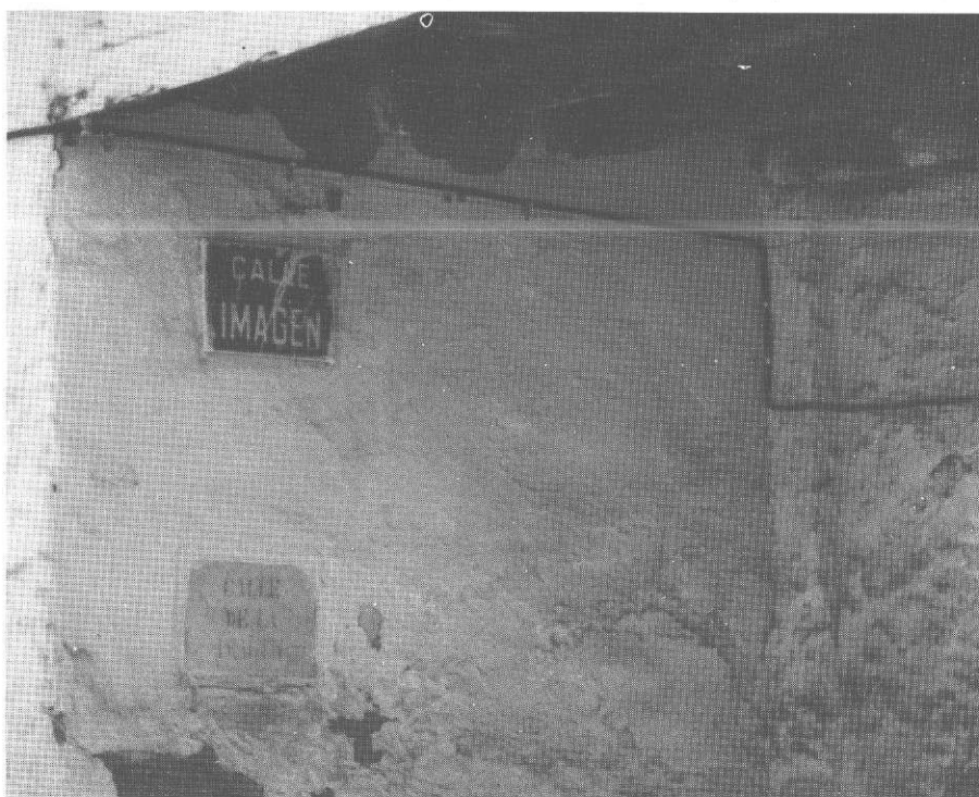
Cableado del Arco de Santa Ana. Foto Tati.
