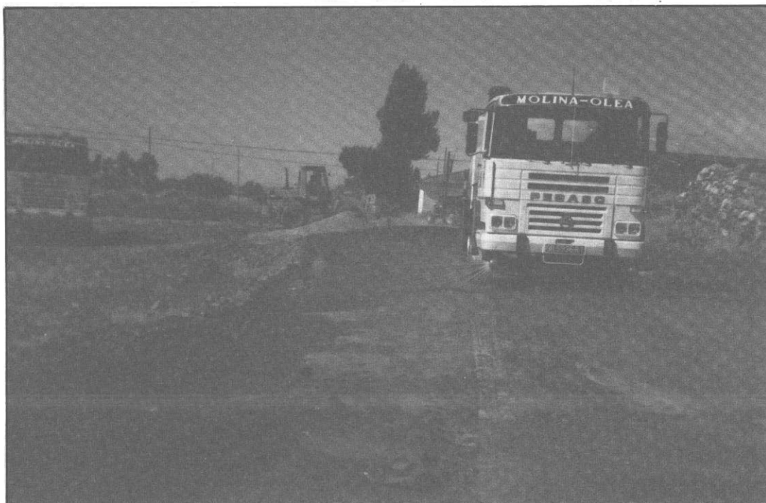
Reparaciones en Cogollos.
