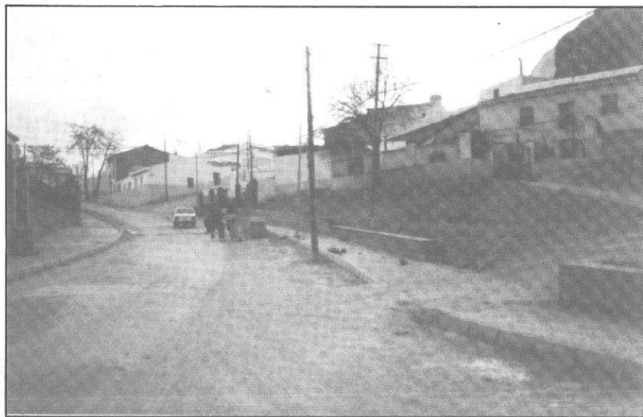
Obras de urbanización en Cañada de los Perales.
