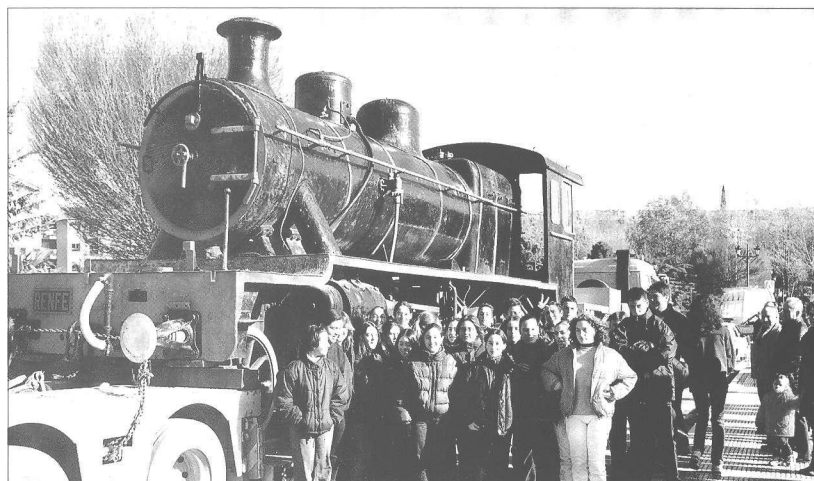
La Babwil antes de su reparación
