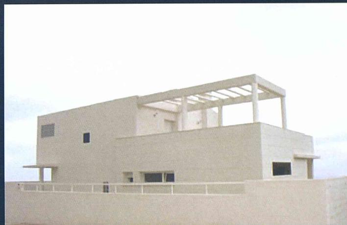
Ventanas con acristalamientos de espesor min. 18mm. para reducción de la transmisión térmica y orientadas con el fin de obtener el máximo frescor en verano.
