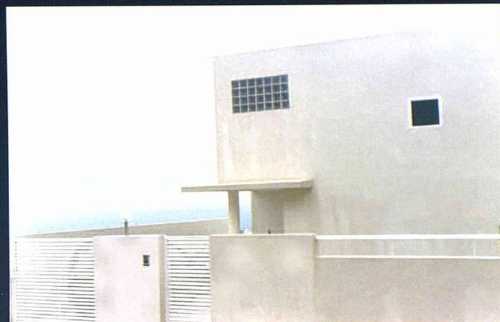
Empleo de la termoarcilla en los cerramientos, material ecológico y con óptimas cualidades térmicas. Cubiertas planas con aislamiento térmico a base de arcilla expandida (arlita).
