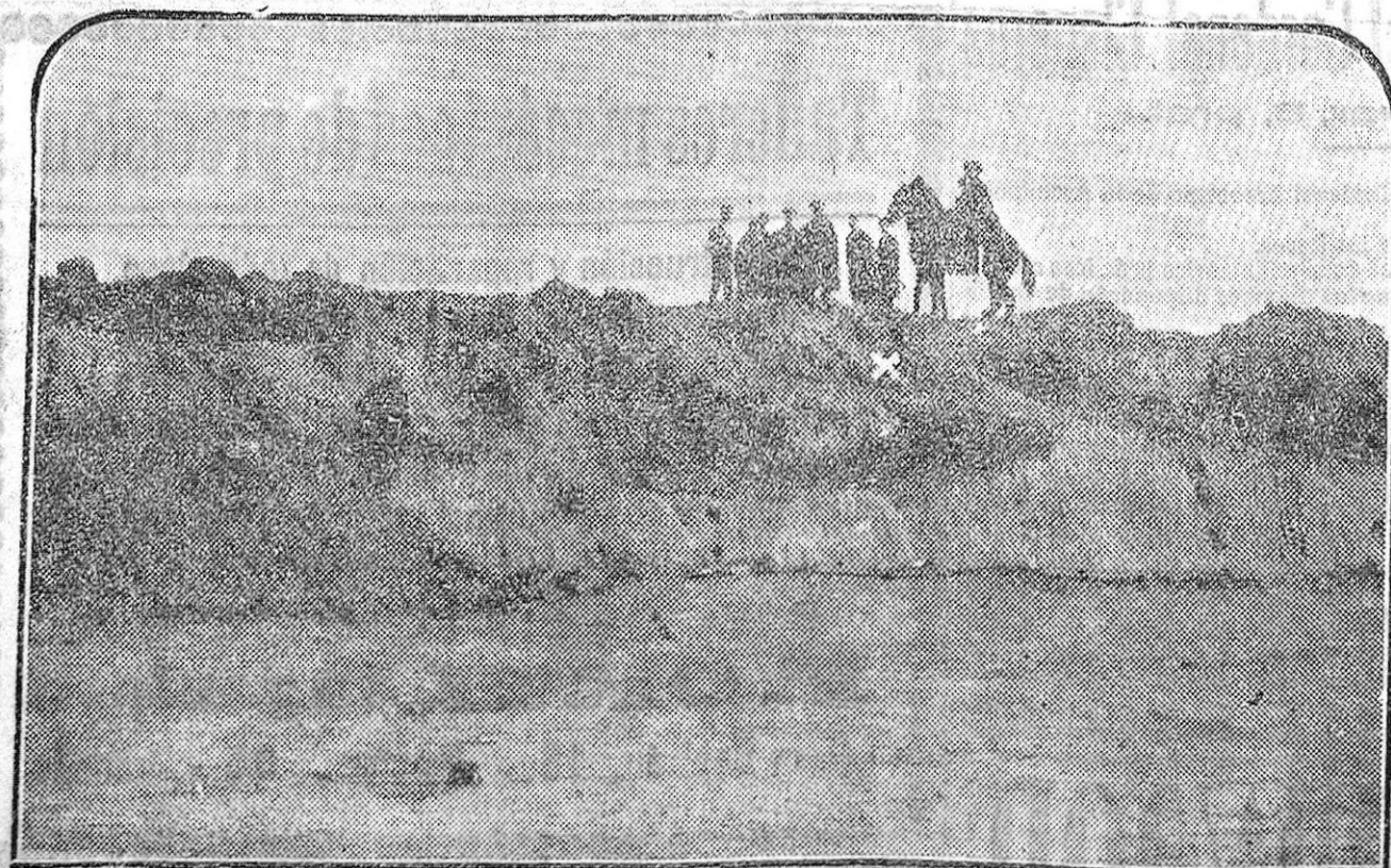
MADRID.—El hallazgo de restos humanos en la calle de Cea Bermúdez. Lugar donde aparecieron los restos, vigilado por la Guardia civil, para evitar la aglomeración de público.
