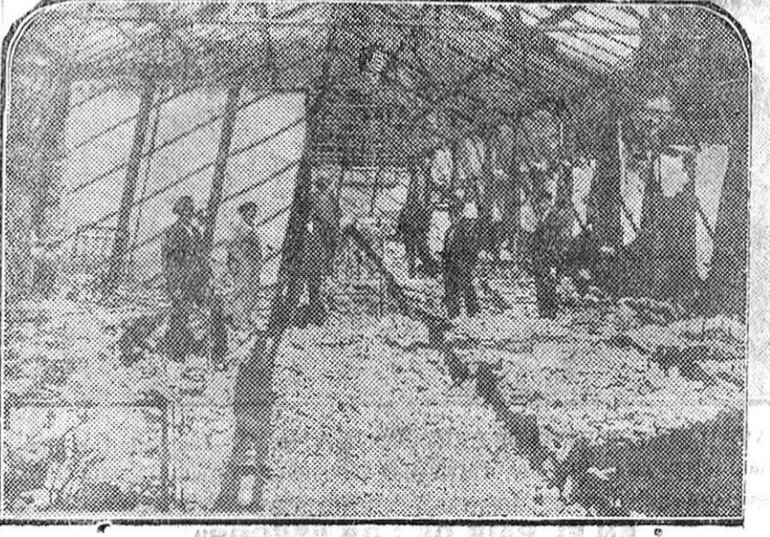
He aquí cómo ha quedado la estación de Canfranc después del incendio que destruyó casi todo el edificio.
