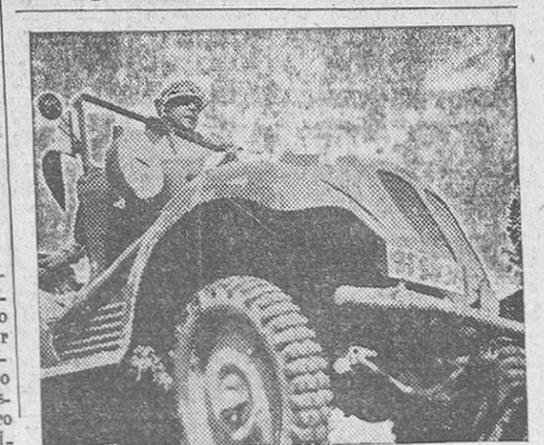
Los coches especiales de construcción alemana permiten una marcha ideal por los terrenos más difíciles con sus cuatro ruedas motrices y los ejes articulados
