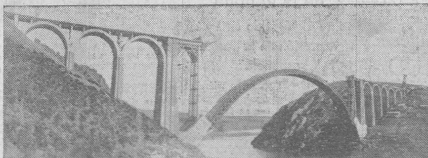
Viaducto en construcción del F. C. de Zamora a la Coruña, sobre el embalse del Esla. El arco central es de hormigón armado, y tiene 197 metros de luz, lo que le hace ser el mejor de Europa.—(Cifra)
