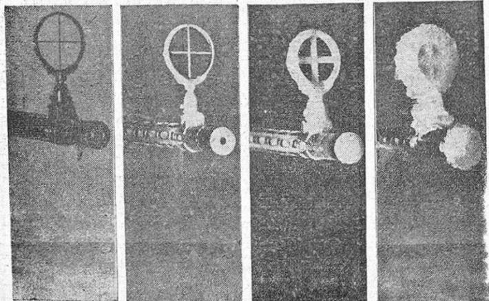
Cuando un avión se mantiene bastante tiempo a grandes alturas, algunas de sus partes se recubren de una capa de hielo que causa alteraciones, no sólo por el aumento de peso, sino por poner en grave peligro la seguridad del aparato. Las fotos recogen varias vistas del cañón de una ametralladora según va siendo recubierto por el hielo.
