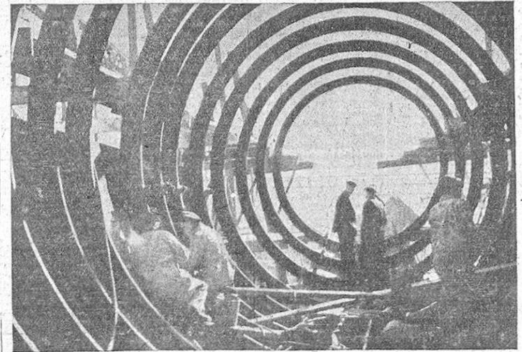
Felizmente, en los arsenales alemanes se sigue la construcción de submarinos. En serie son construidos por obreros especializados, que aquí, en el esqueleto de un nuevo sumergible, se afanan en soldar eléctricamente las cuadernas.
