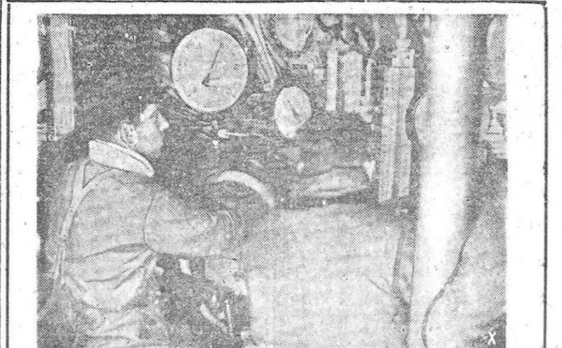
A BORDO DE UN SUBMARINO ALEMAN. Los timoneles del timón de profundidad mantienen el submarino en la profundidad ordenada. El puesto exige toda atención.
