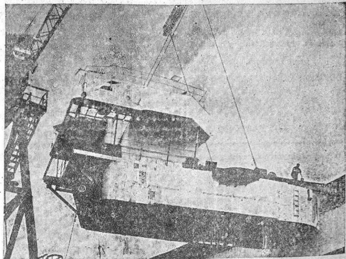
Una grúa iza, para ser colocado en su lugar, el castillo de proa de un destructor en construcción.—(Foto BLACK).
