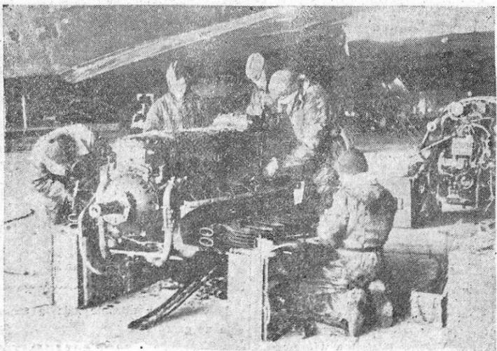
Los motores con el corazón de cada avión alemán. Después de ciertas horas de su funcionamiento, tienen que ser desmontados completamente para ser engrasados y arreglados, garantizando de este modo un funcionamiento perfecto. (Foto ORBIS).
