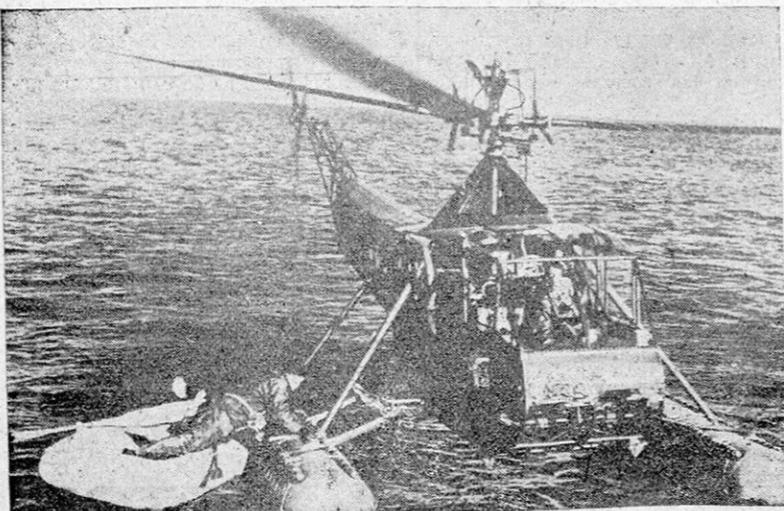
Un piloto norteamericano del servicio de guardacostas, posa su aparato de alas rotatorias junto a un marineru, para que éste pueda pasar desde su baliza salvavidas al flotador del avión y de allí a una hiteru en forma de cesta; luego el helicóptero despegará verticalmente volando a muy poca velocidad. (Foto WHITE).
