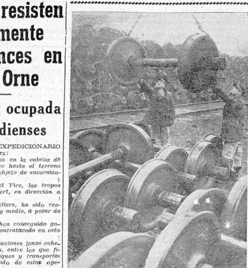
En Inglaterra se procede a montar trenes para la invasión con piezas prefabricadas en los EE. UU. He aquí el momento de izar unas ruedas para montarlas en un camión, en un depósito.—(Foto WHITE).
