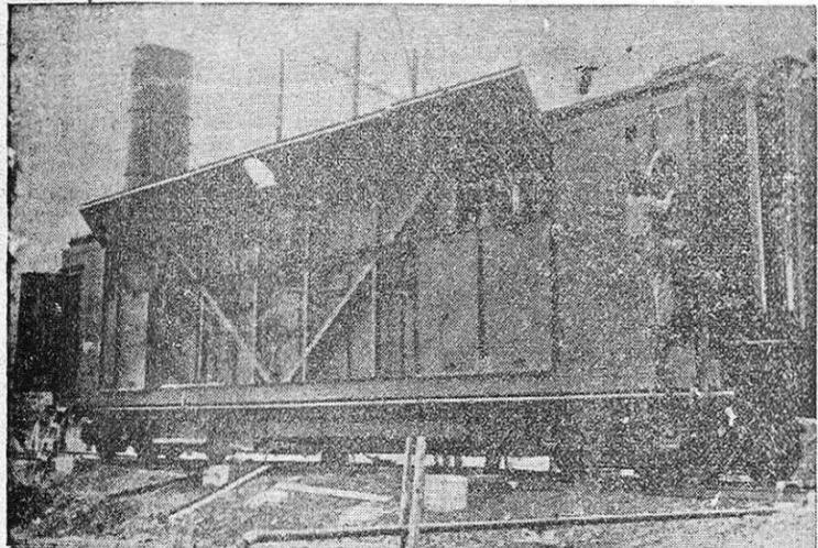
Un obrero norteamericano efectúa la inspección final de una máquina, que forma parte de un tren de ocho vagones, que facilitará energía eléctrica a las ciudades conquistadas por las tropas aliadas.—(Foto WHITE).
