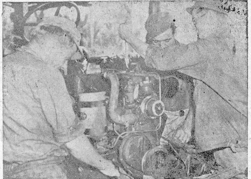
Soldados norteamericanos instalando los cables del freno y el carburador del motor en un camión de dos toneladas y media, en una línea de montaje de campaña, en una base de material del Ejército norteamericano en Nueva Guinea.—(Foto WHITE).
