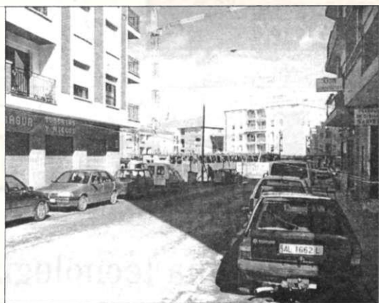
Calle Manuel de Falla
