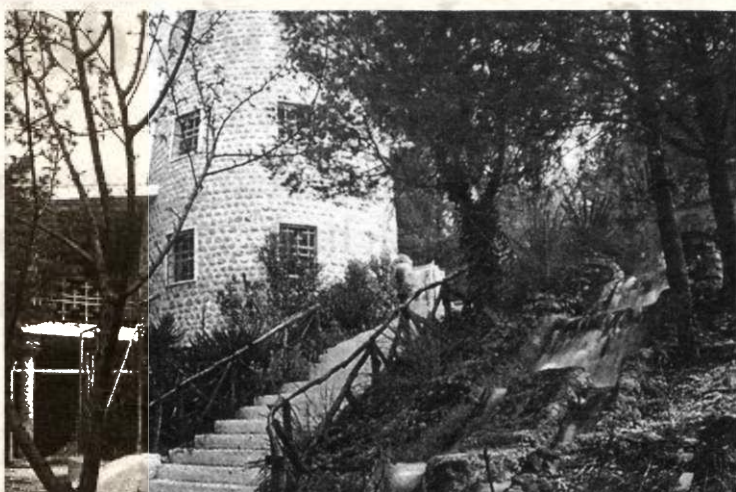
La carretera que conduce al balneario se mejorará.
