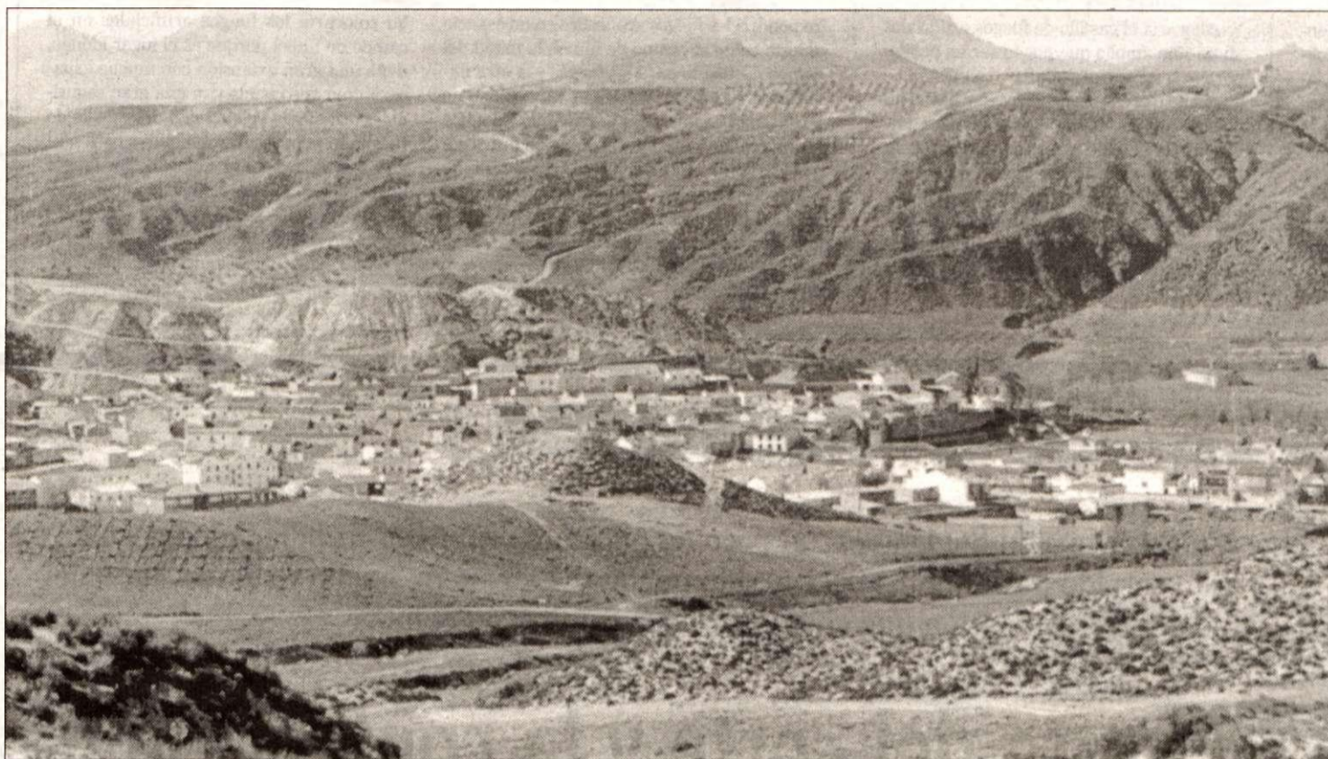
En Alamedilla reivindicaron la reforma del puente Hacho.
