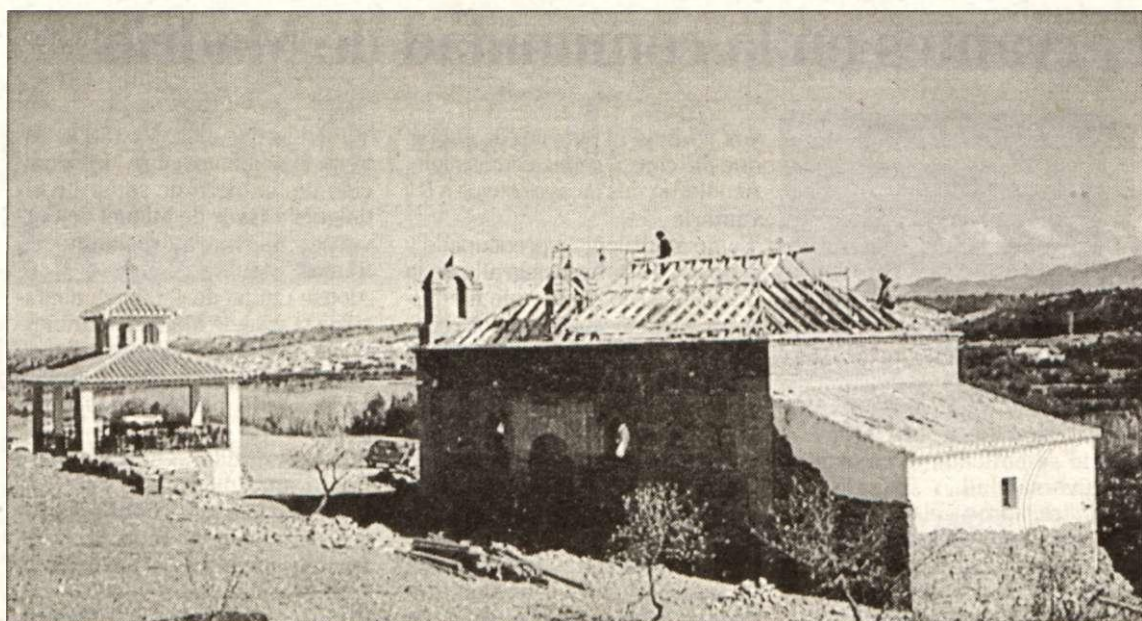
Restauración de la ermita del Zalabí.
