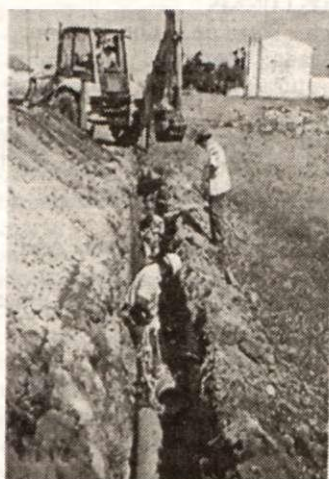
Construcción de colectores de Hernán-Valle
