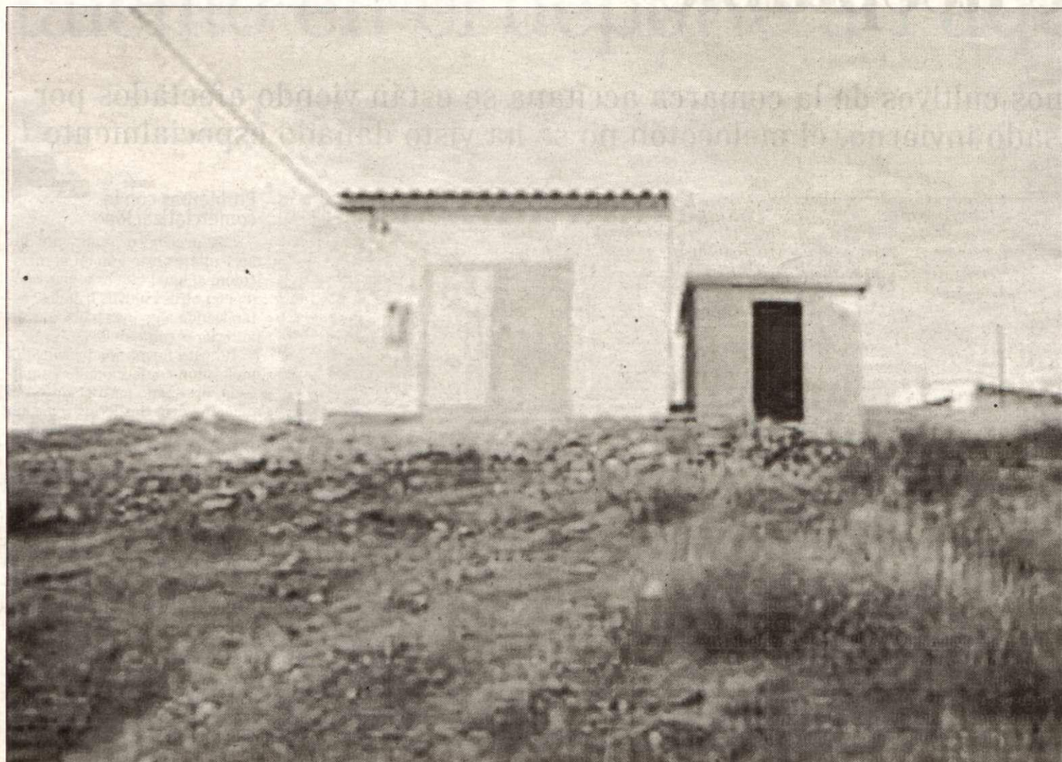
Nueva instalación para la mejora del suministro de agua potable en Lugros.
