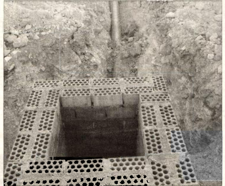
Obra llevada a cabo en la zona.
