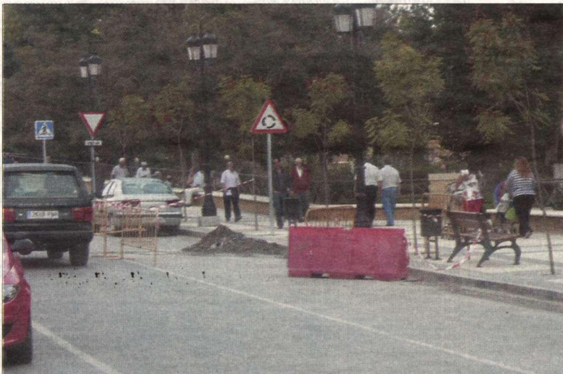
Nuevos trabajos en una zona que a priori parecía acabada.
