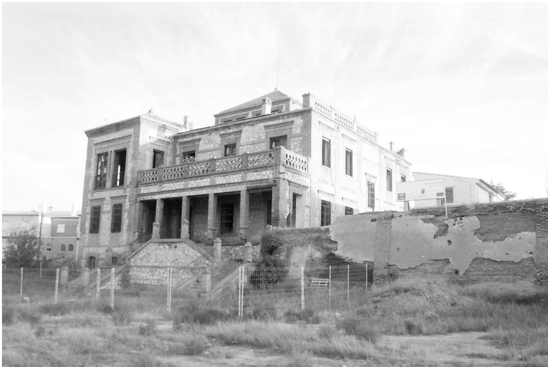
Edificio que se rehabilitará en la azucarera de Guadix.
