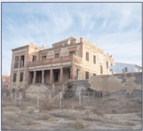
Edificio a rehabilitar.
