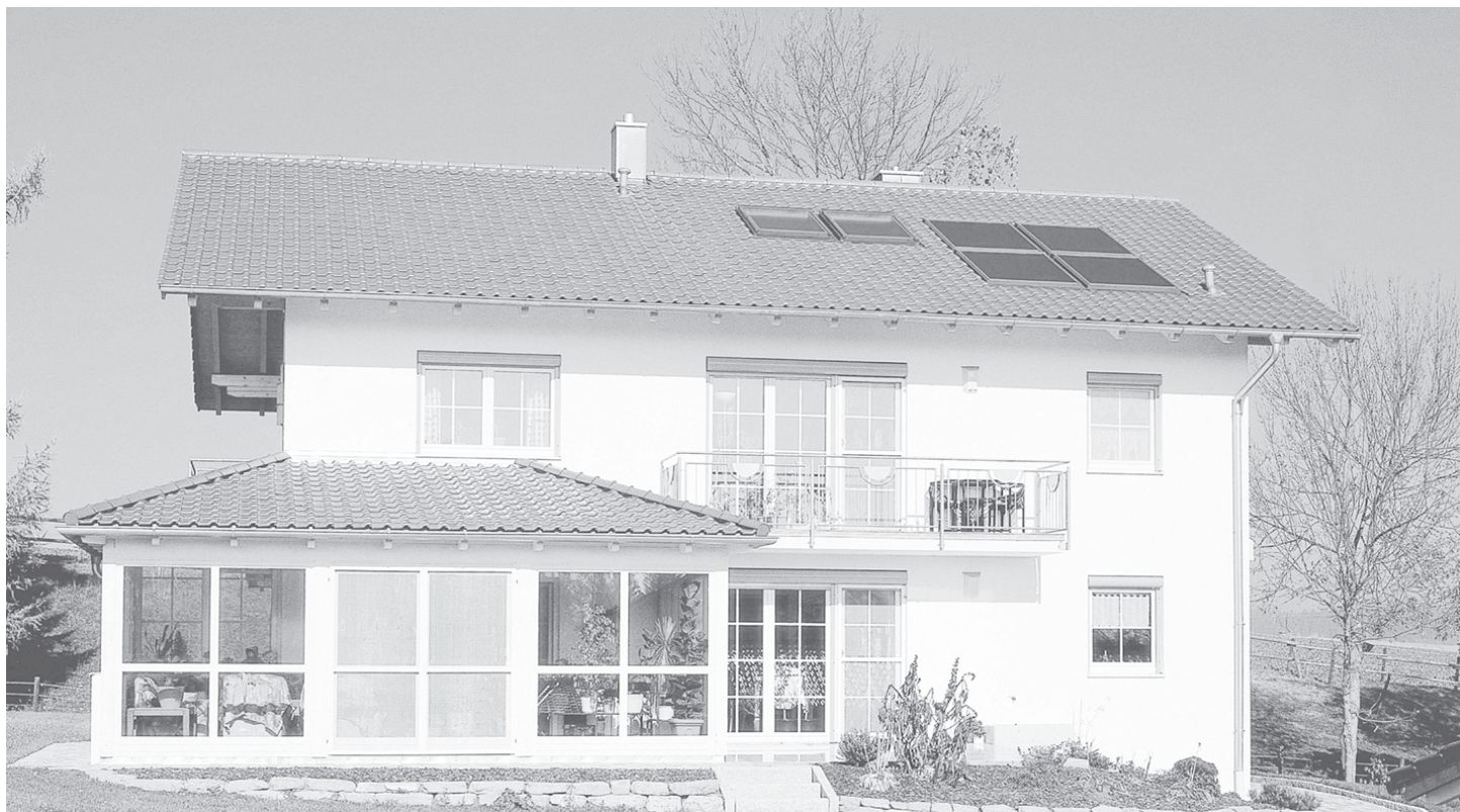
La Junta de Andalucía seguirá fomentando la instalación de sistemas de energía alternativa en los hogares andaluces.
