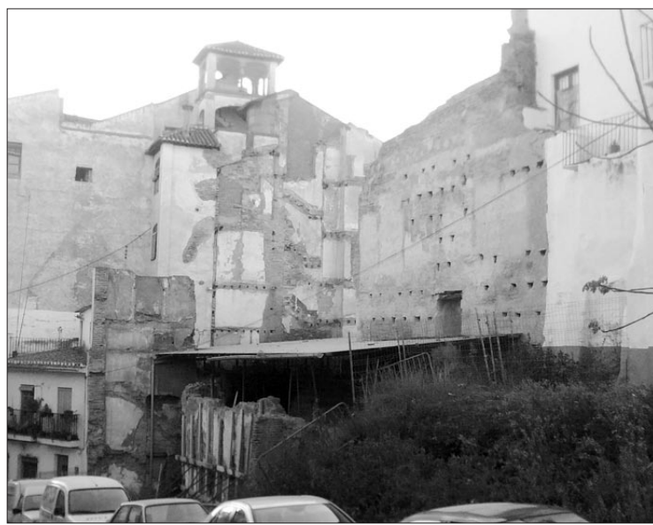
Parte de atrás de este solar.
