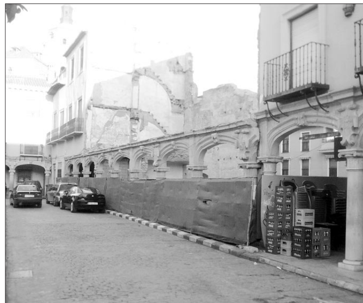
Zona que da a la Plaza donde se construirá el edificio.
