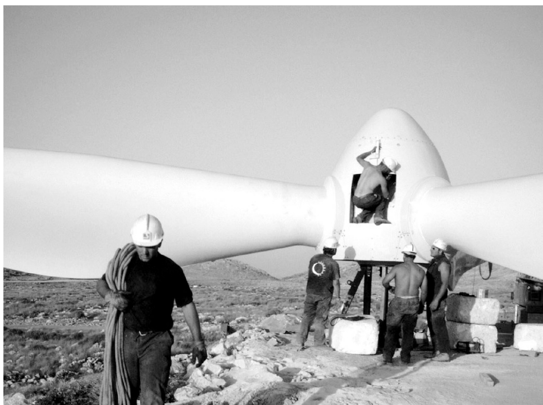
La instalación de una hélice da una idea de las dimensiones de algunos de estos modernos molinos de viento.
