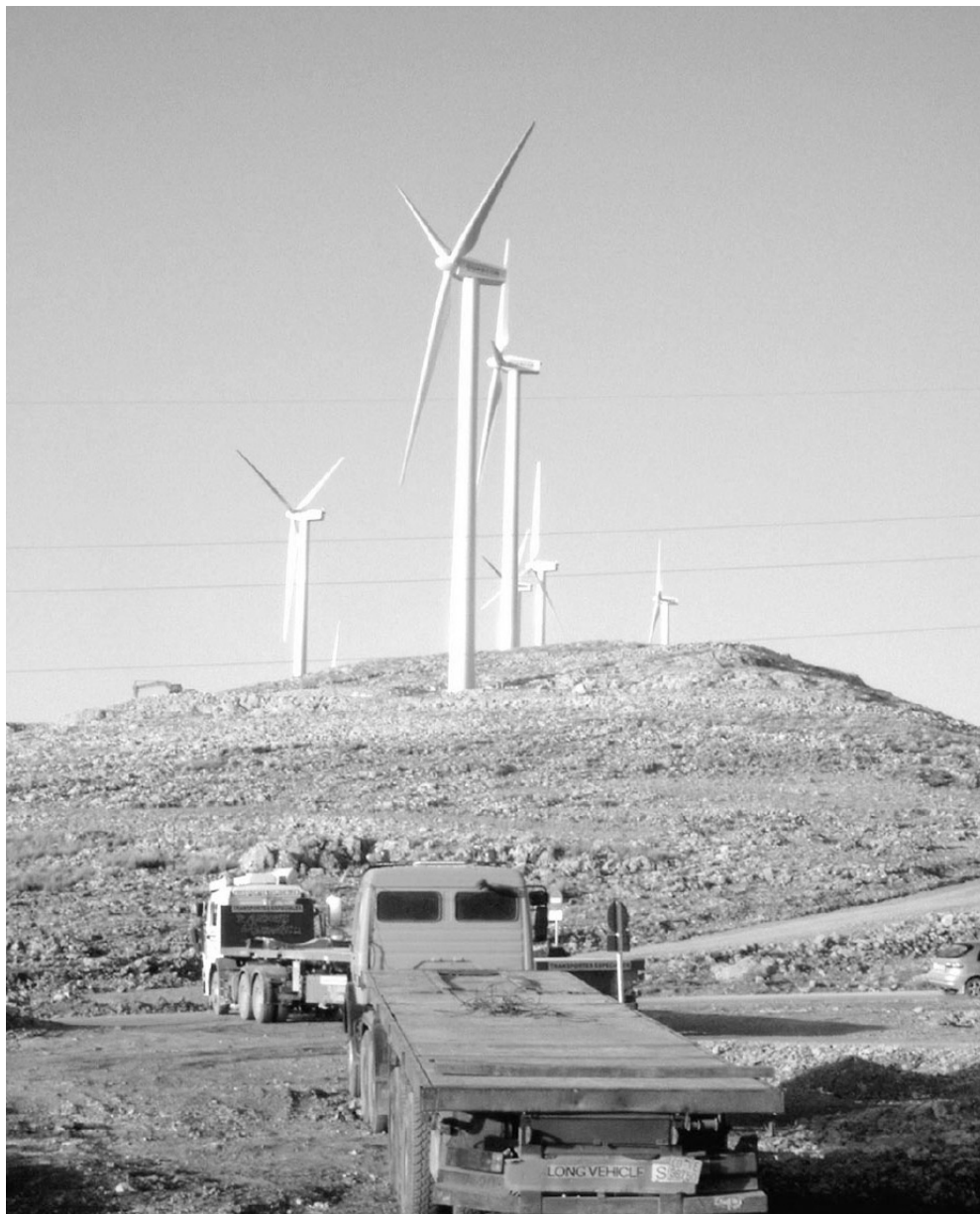
Los trabajos previos de instalación del parque eólico ubicado en Loja, inaugurado en 2004.
