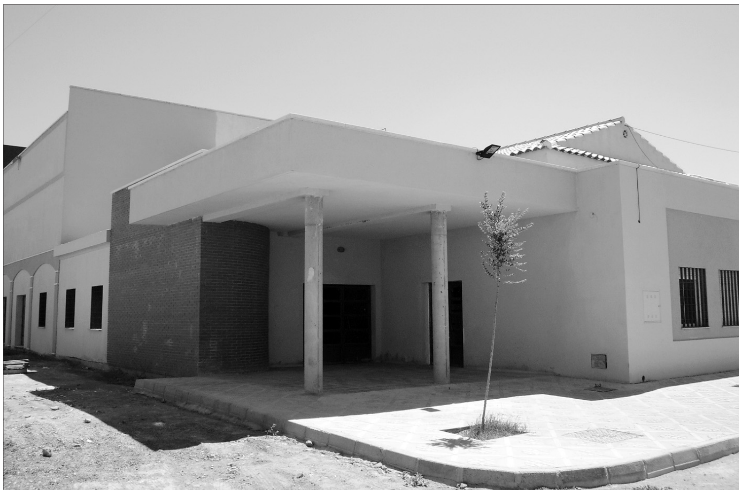
Fachada del edificio de usos múltiples, a la entrada de Albuñán, que servirá de sede para el evento
