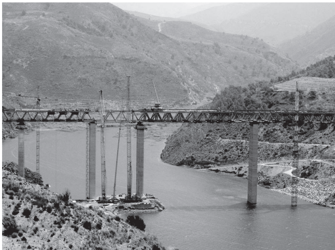
Parte de las infraestructuras -en la imagen, la presa de Rules- serán financiadas a través de los cánones.
