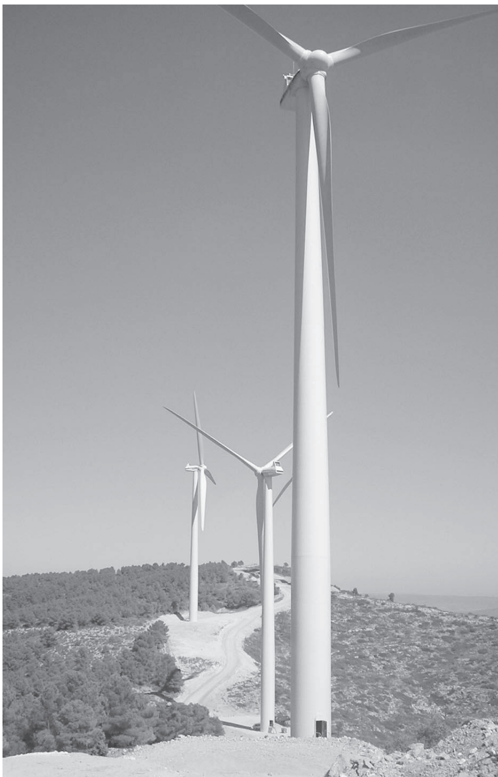
La presencia de molinos eólicos se ha convertido en algo habitual en muchas zonas de Andalucía.
