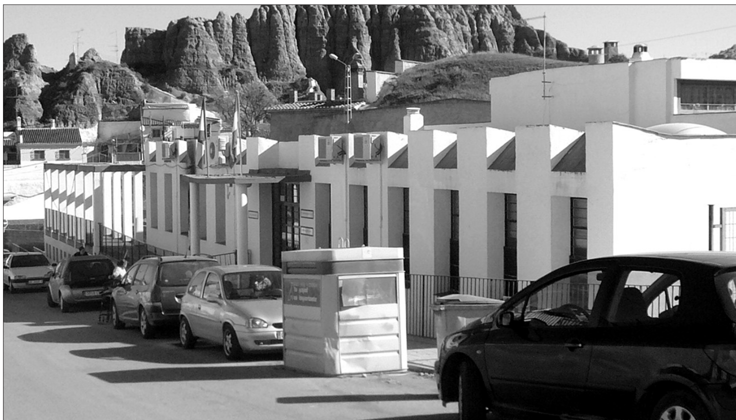
Centro de Servicios Sociales del Ayuntamiento de Guadix.
