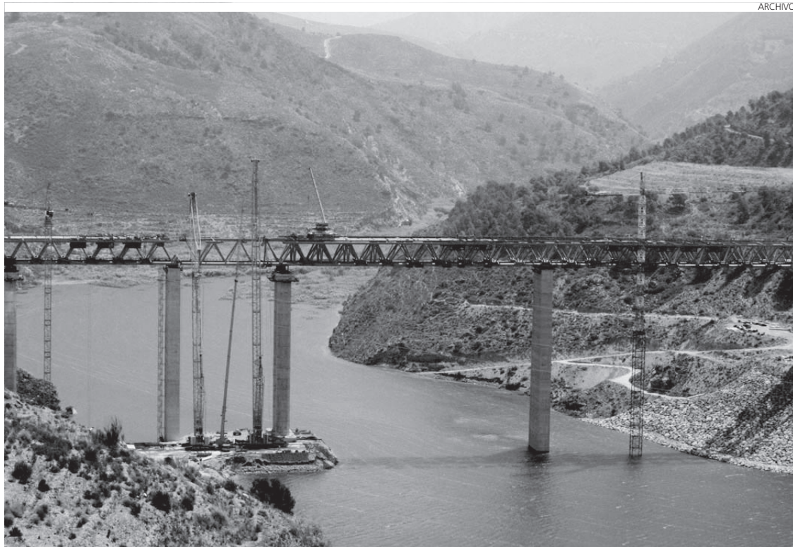
Entre los puestos de trabajo más demandados en Andalucía en el último año se encuentra el de jefe de obra civil.
