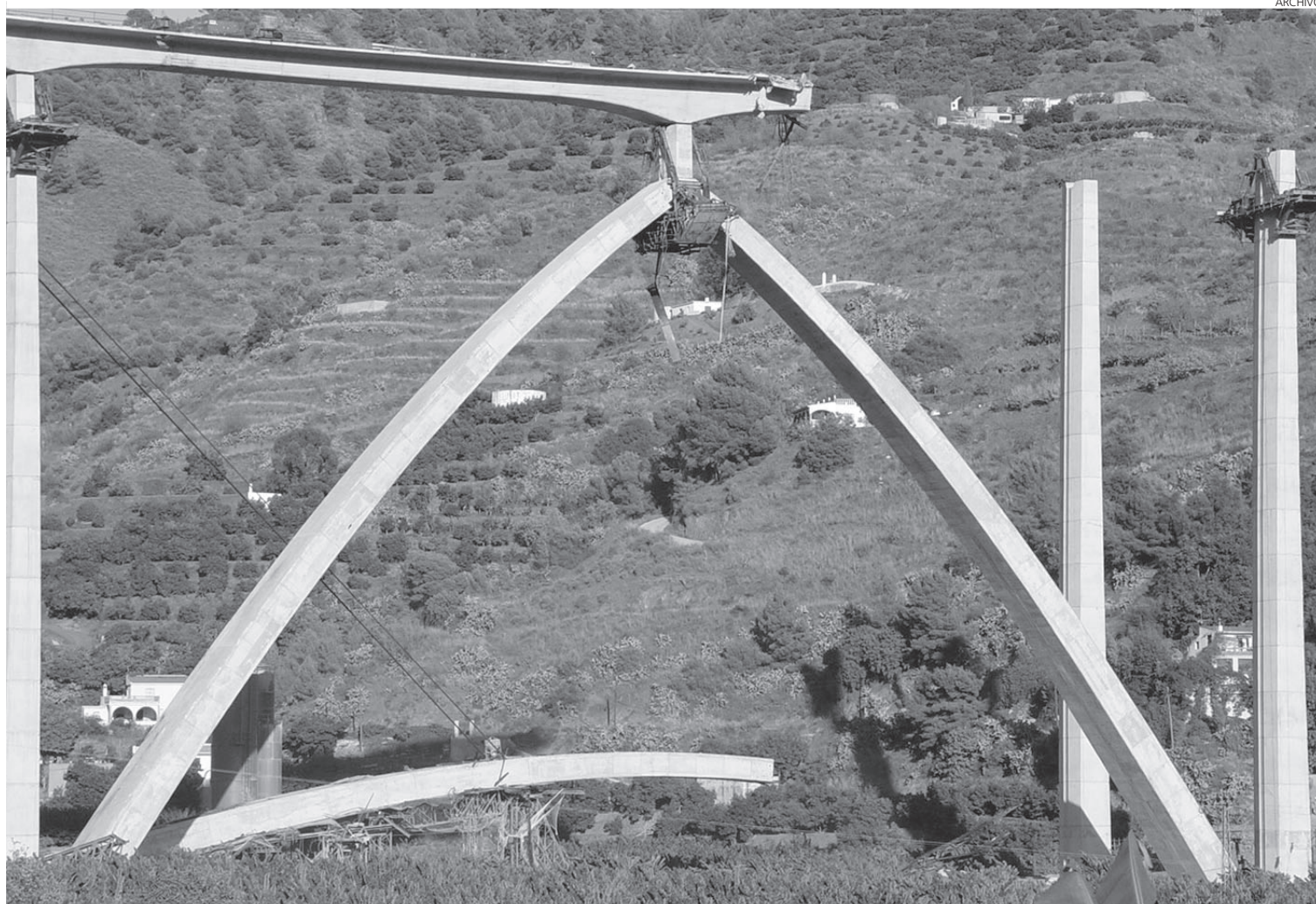
Cinco trabajadores fallecieron en noviembre de 2005 tras derrumbarse la cimbra colocada para construir el acueducto de la A-7 a su paso por Almuñécar.
