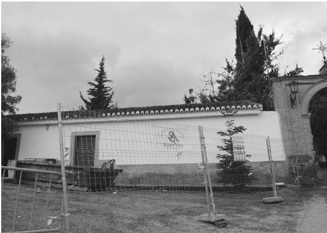
Primeras obras del Fondo de Inversión Local.
