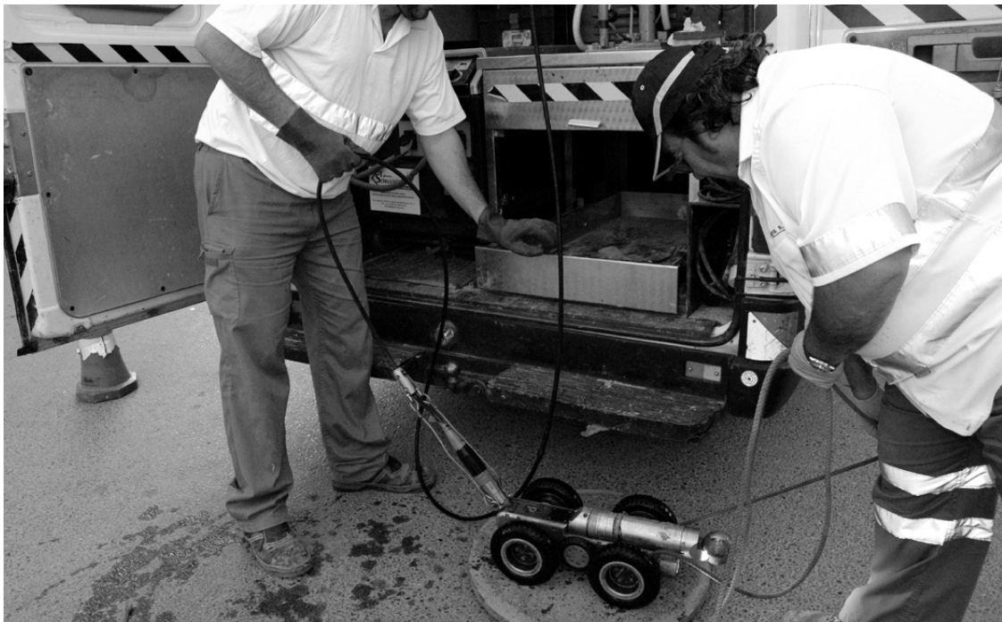
Los operarios de Aguas de Guadix preparan la cámara.
