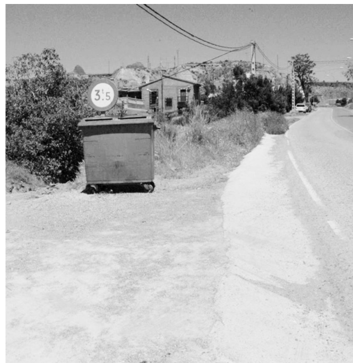
Zona en la que se está actuando.
