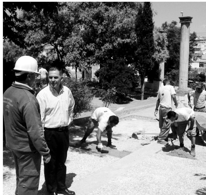
El alcalde de Guadix durante la visita a las obras.
