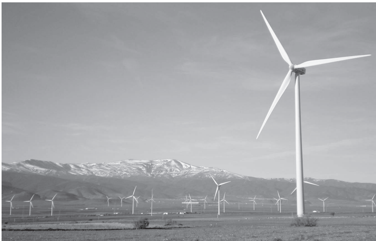
La Comunidad cuenta actualmente con 2.169,3 MW de potencia de energía eólica en funcionamiento, generando el 58% de la energía renovable.
