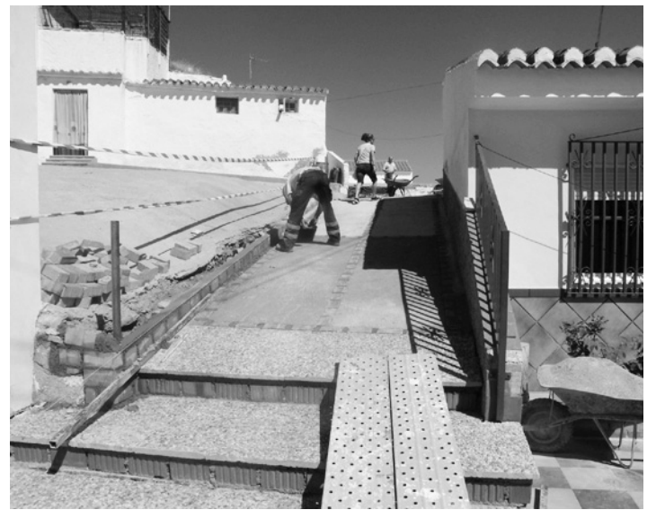
Una de las obras que se están llevando a cabo.
