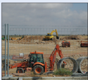
Obras de Mercadona.
