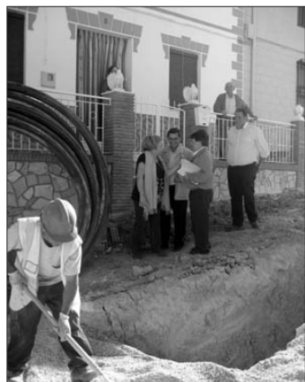
Obras en Turro.
