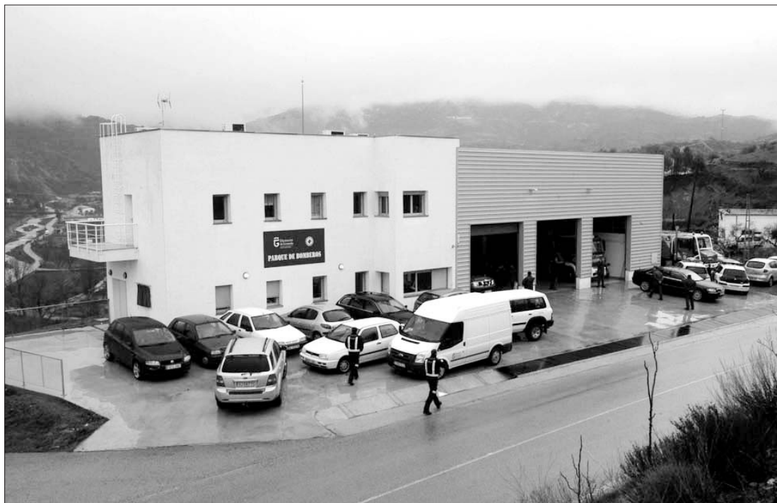
Nuevo Parque de Bomberos de Cádiar.
