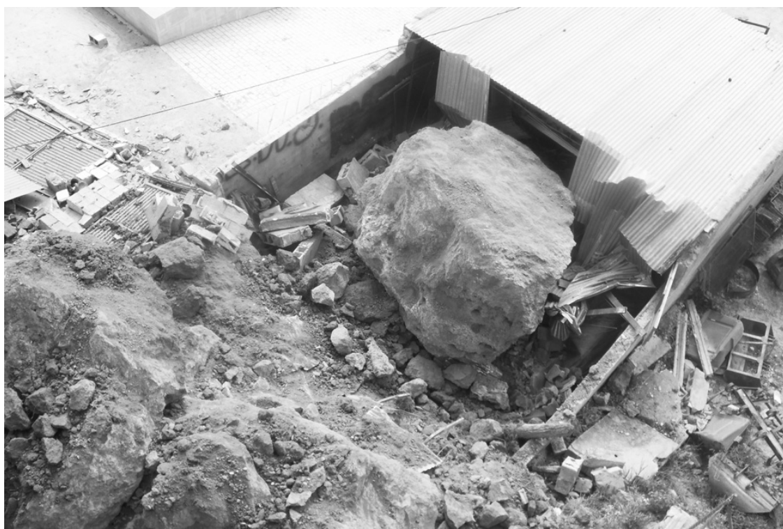
Derrumbe producido en Cortes y Graena.
