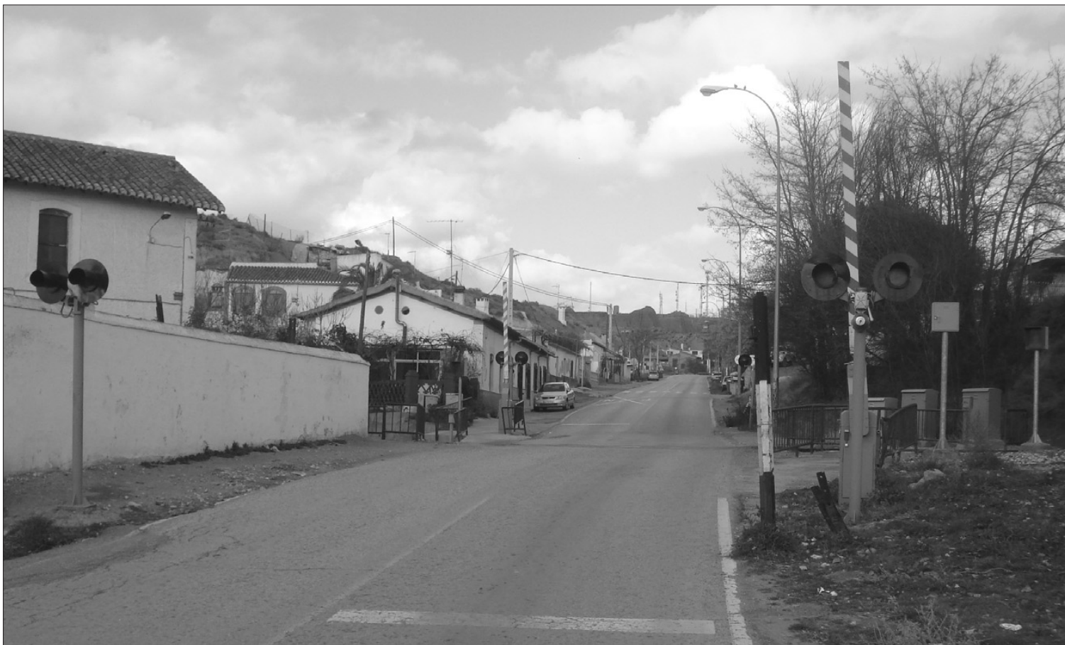
Paso a nivel de Guadix.
